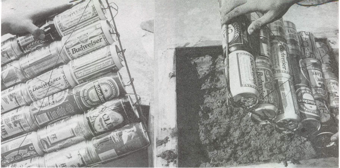
Fabricación de Paneles con latas de aluminio.
