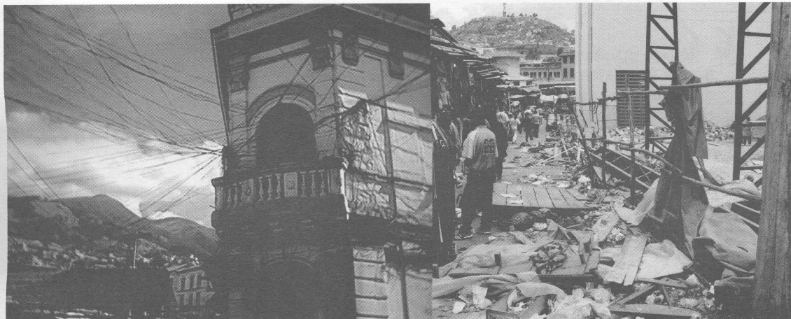
Redes eléctricas enmarañadas contaminación ambiental
