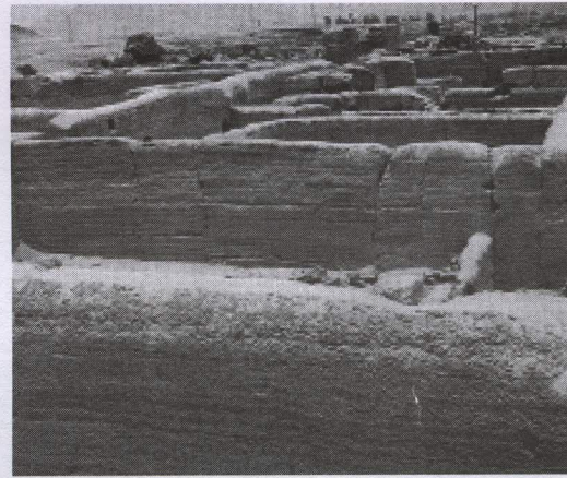
Muros de tapial en Cajamarquilla (Agurto, 1984, pag. 11)
