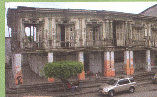
Casa Municipal de Vinces: 2007 Foto: Arq. Claudia Peralta
