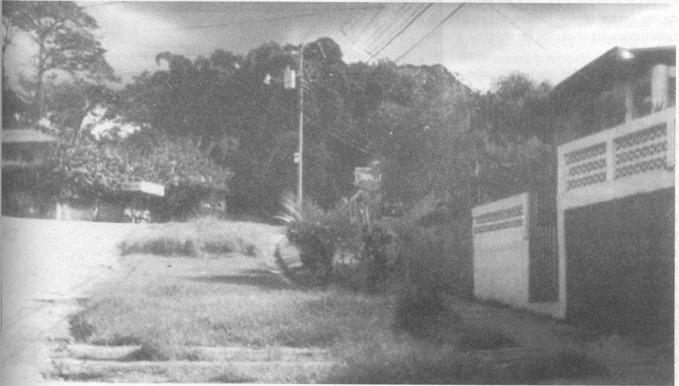
Foto 1 Hasta el año 1987, las normas urbanísticas en Costa Rica fijaban calzadas de 5.5 a 7.5 metros calles para secundarias y terciarias de las urbanizaciones, pero debían mantener un derecho de vía de 14 metros para permitir su eventual ampliación. La foto ilustra el resultado de la implementación de esta norma.
