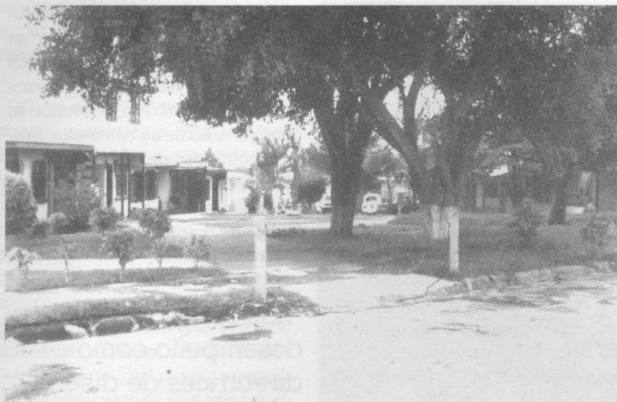
Foto 3 Este espacio multi-uso, que sirve como entrada de vehículos, parqueo, área recreativa y área de acceso al conjunto de casas, demuestra que este concepto, no permitido con la normativa actual, puede producir entornos agradables en áreas frente a las casas.
