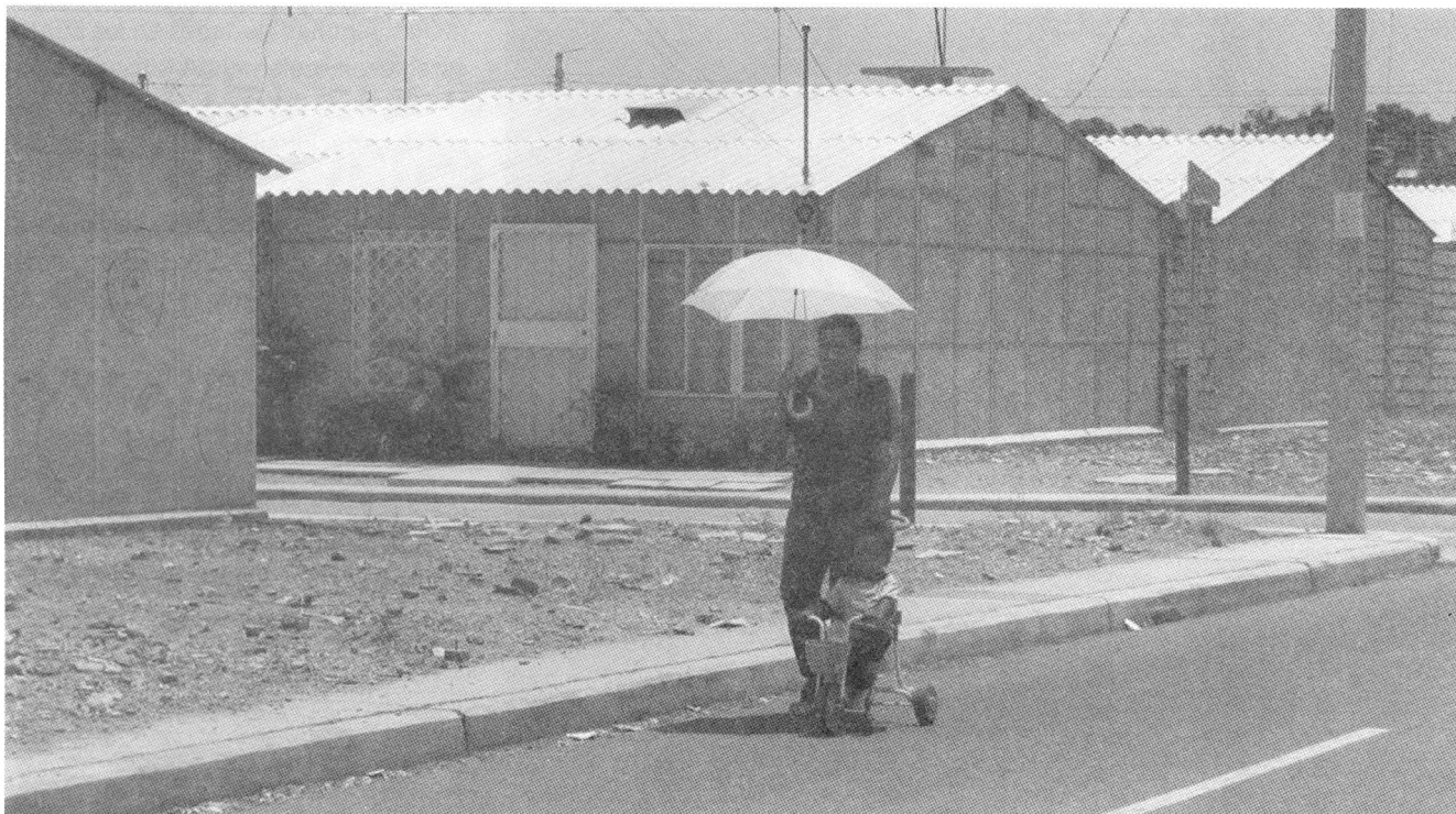
Foto 3 En esta vivienda recientemente construida en el área de Guayaquil, Ecuador, los aspectos climáticos no se tuvieron en cuenta. Fuente Erik Johansson
