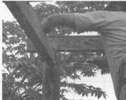
Fotos 5 y 6 Conexión por medio de pernos de vigas y pilares.
