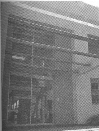
Foto 4. Proyecto de vivienda de interés social " El Roble" 90 m 2 , en el Sur de Quito. Propietario del lote Coop de vivienda "San Gregorio"
