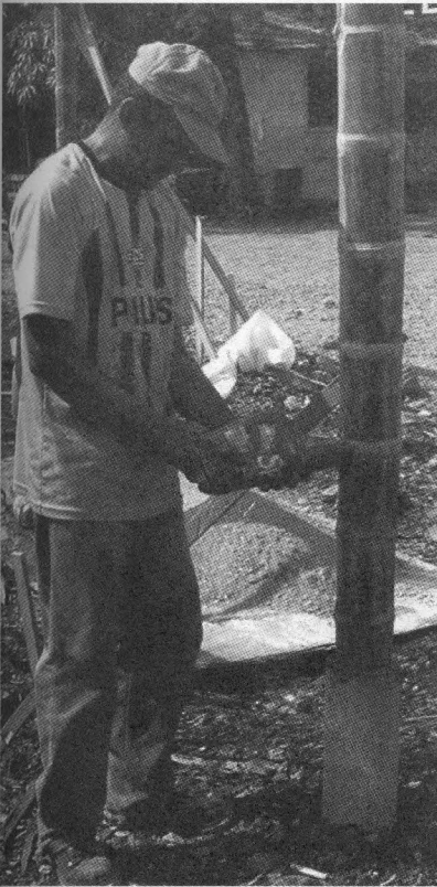
Foto 4 Sistema de conexión entre la base de hormigón y el pilar.
