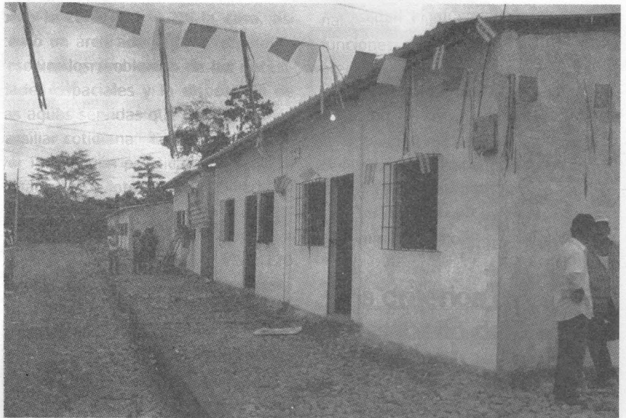
Foto 2. Viviendas construidas con el Bono entregado por el MIDUVI Fuente MIDUVI, 2008
