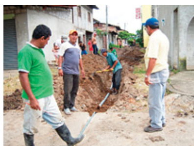
Foto No. 11 Implementación de redes para suministro de agua potable en zonas urbano marginales, Balzar Fuente: http://www.balzar.gov.ec
