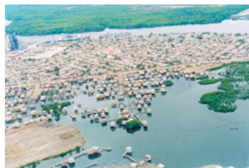
Foto 8. Evidente imagen de inestabilidad estructural-constructiva y social.
