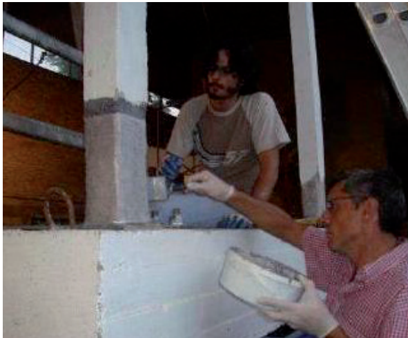
c) Colocación capa final de adhesivo.
