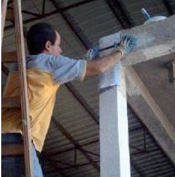
b) Colocación de fibra.
