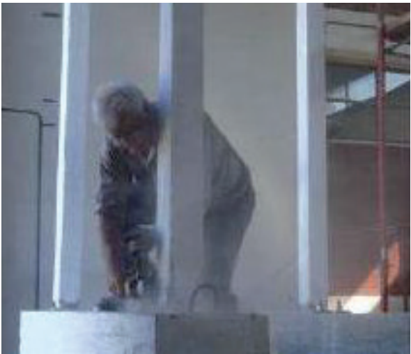
a) Limpieza de superficie.
