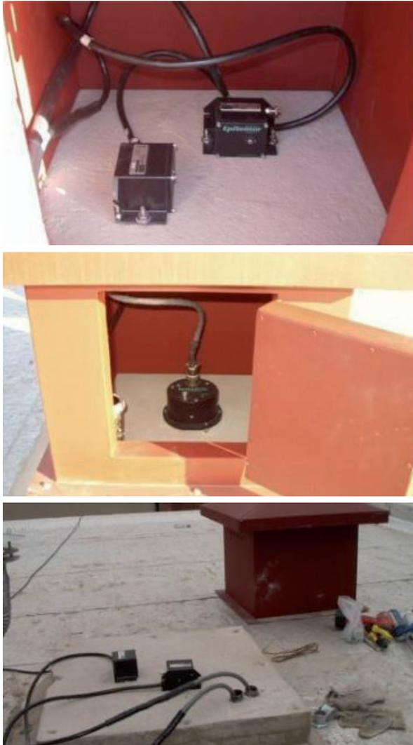
Figura 6. Sensores sísmicos instalados en el edificio aislado y en el edificio con base fija.
