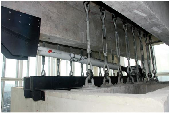
**Figura 14.** AMS con amortiguador.
