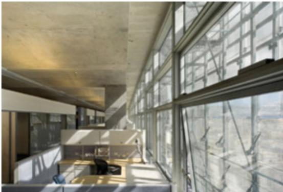
**FIG. 5:** Vista interior de espacio de oficina naturalmente ventilado. Las ventanas son divididas en paneles para controlar las condiciones de ventilación.
