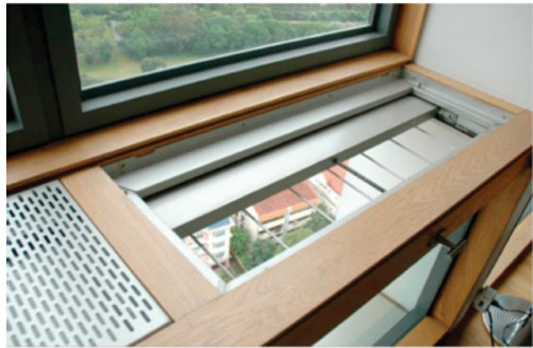
**FIG. 7:** Ventana para el monzón, con sistema regulable para el flujo de aire.
