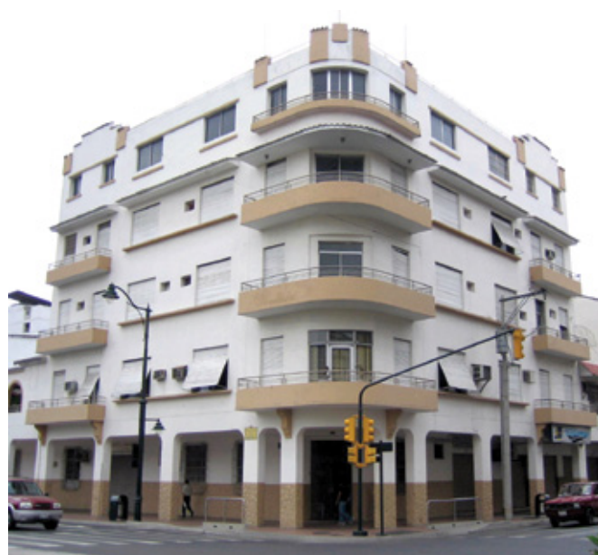
Imagen 7: Edificio Marcet. Arq. Héctor Martínez Torres,
