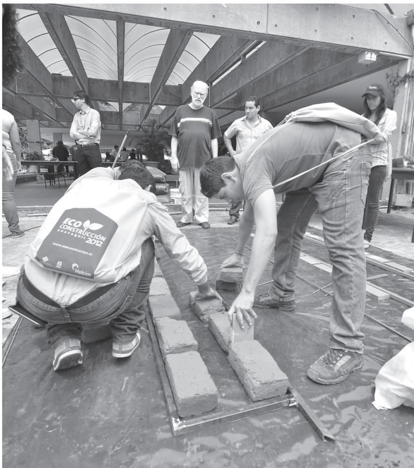
Fig.015| Arq. Aurelio Ferrero supervisando el trabajo de armado de placas BENO realizado por asistentes de su taller.
